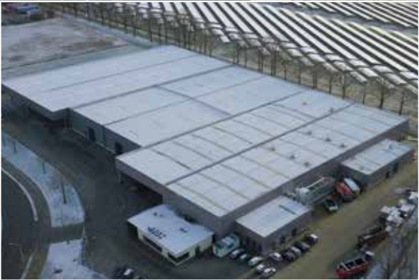
Emmen, Produktionshallen und Warenlager
